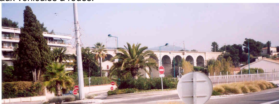
Le viaduc SNCF de Bandol.
